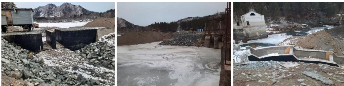
Фото 2 Капитальный ремонт ГТС Чемальская ГЭС на реке Чемал
