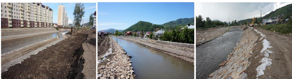
Фото 1 Сооружения инженерной защиты г. Горно-Алтайска от вод р. Майма
