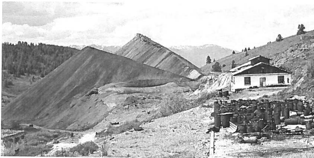
Фото 18 Терриконы огарков, шламоотстойник и скопление бочек с РСО на площадке временного хранения в промзоне АГМП
