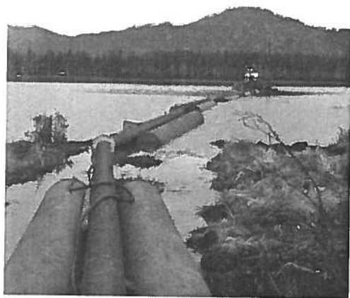
Фото 24 Извлечение и транспортировка донных илов земснарядом
